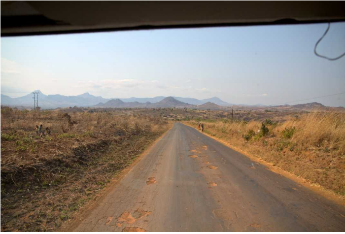
Viele Schlaglöcher auf der Straße zur Grenze
