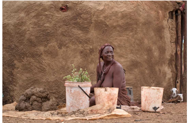
Die Hütte wird mit einem Kuhfladengemisch ausgebessert.
